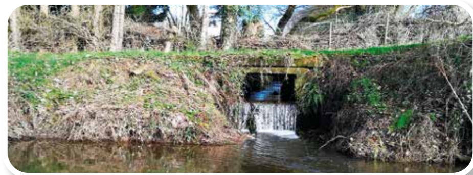
> Ouvrage infranchissable par le poisson
