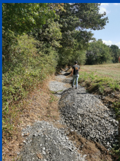
Photo de la deuxième partie du cours d'eau après travaux
