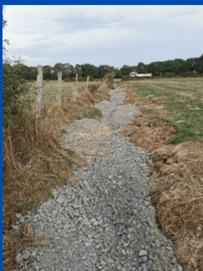
Photo de la première partie du cours d'eau après travaux
