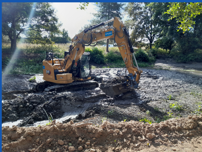
Désenvasement d'un des plan d'eau
