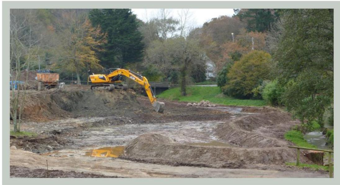
Illustration d'un merlon maintenu en bord de cours d'eau et d'un bassin tampon permettant d'éviter le départ des sédiments vers le cours d'eau durant le chantier. La pelle mécanique reste sur le remblai pour réaliser le décaissement et éviter de tasser le sol de la zone humide (© Brest Métropole).
