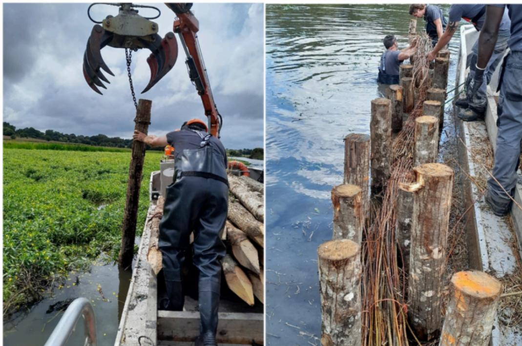
Cette structure agit comme un **piège à sédiments** : lors des décrues, elle favorise le dépôt des particules fines, ce qui accélère le processus de sédimentation et permet à terme la **mise hors d'eau de la Jussie**, réduisant ainsi son développement. Par ailleurs, le lit mineur du Don a été resserré de moitié dans les zones les plus larges, **augmentant la vitesse des écoulements** et rendant les conditions moins favorables à la plante invasive, qui préfère les eaux lentes et peu profondes.
