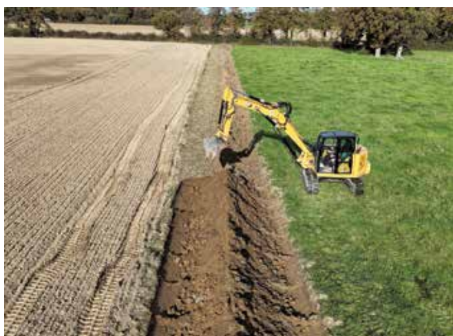
Réalisation de billons en vue d'une plantation de haies.
