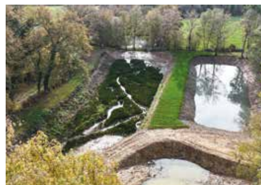
Suppression du plan d'eau, déconnexion du cours d'eau et maintien d'une surface en eau inférieure à 1000m 2 à Ercé-en-Lamée
