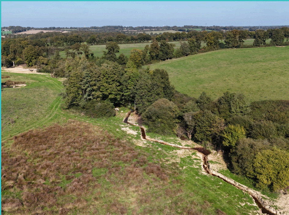
Reméandrage sur le cours d'eau de l'Etang de Fondeluen (Lusanger)
