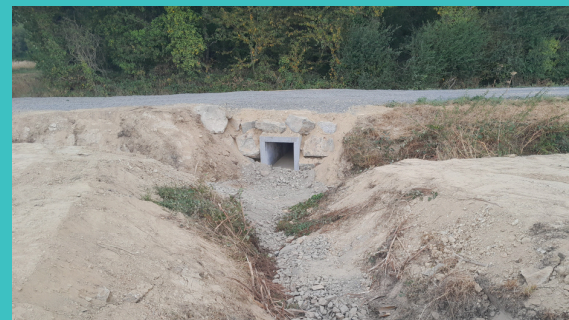
Remplacement d'ouvrage type pont cadre en parallèle de travaux sur le cours d'eau (Jans)
